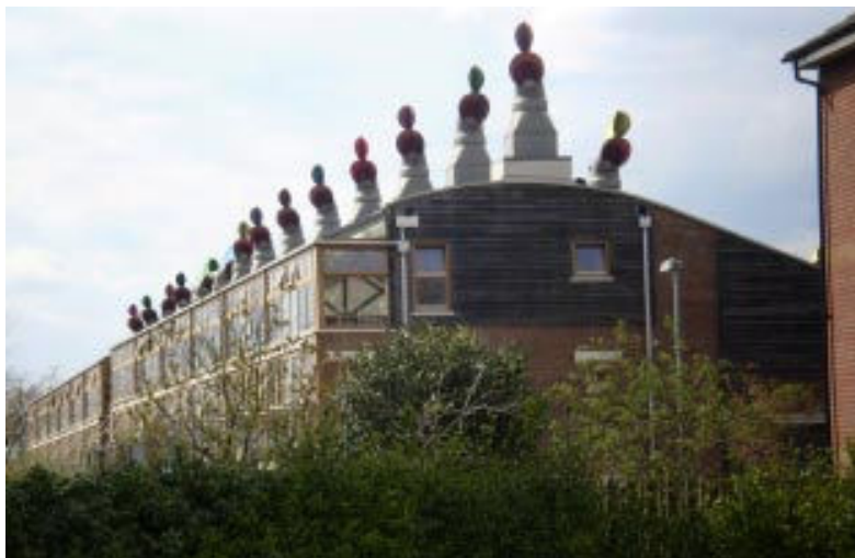
16- Os "capuzes" coloridos instalados nas coberturas
