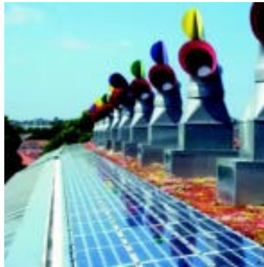
17 - Sistema de células fotovoltaicas
